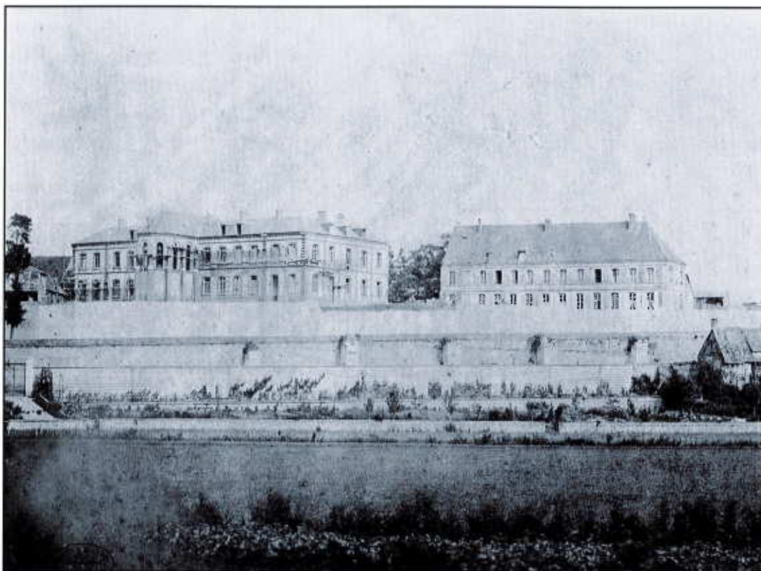
Fig. 6. Hospice de Conches en construction, 1863, photographie sur papier albuminé de Jules Camus. Archives départementales de l'Eure 39F1103. Image numérique retravaillée et éclaircie
